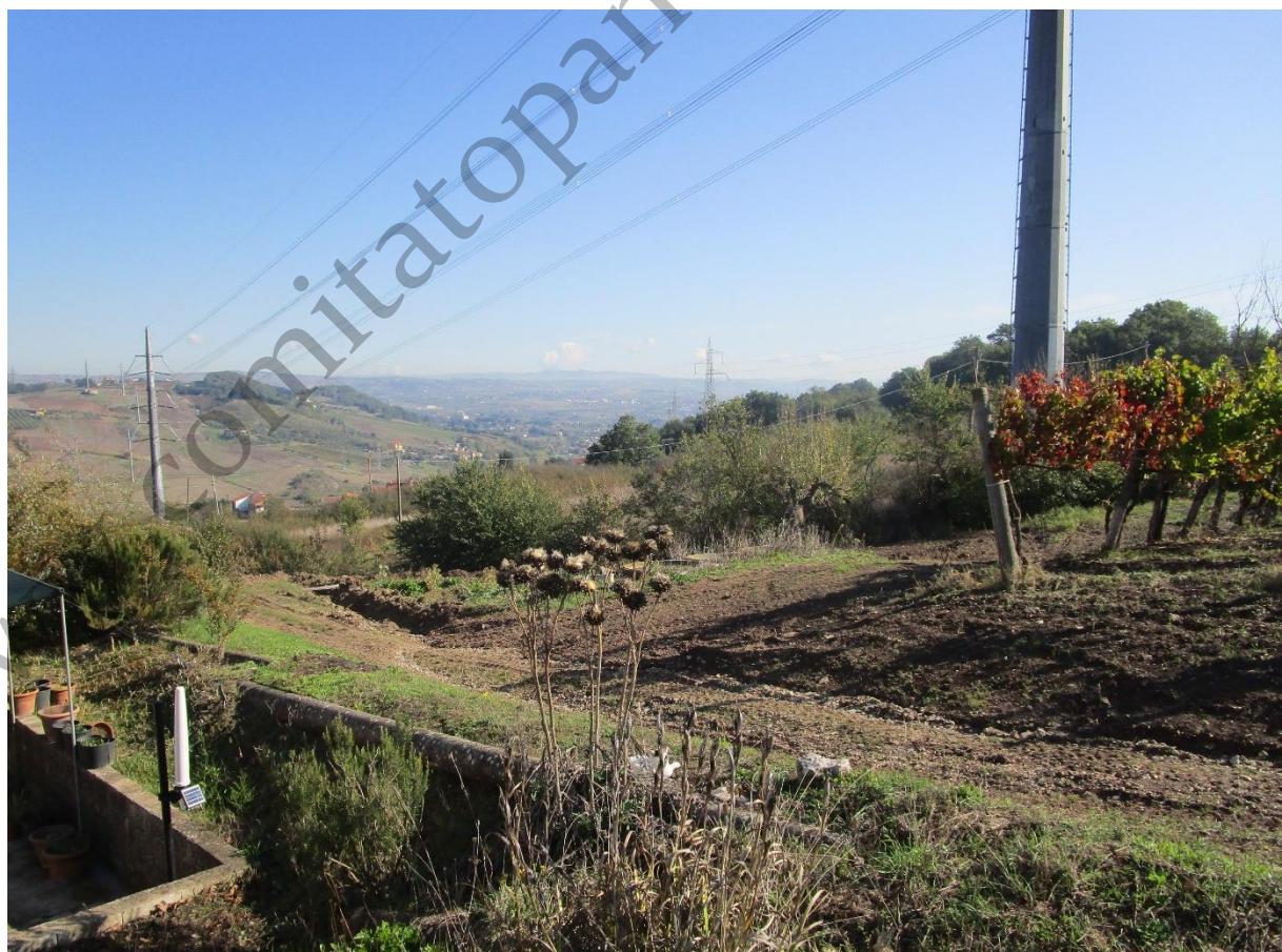
Figura 4 Immagine della centralina installata in contrada Pino
