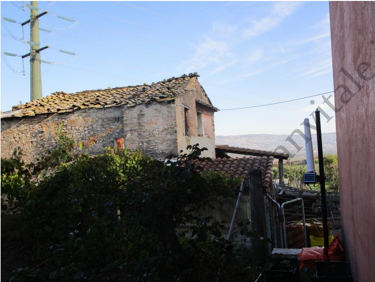
Figura 2 Immagine della centralina installata in contrada San Vitale
